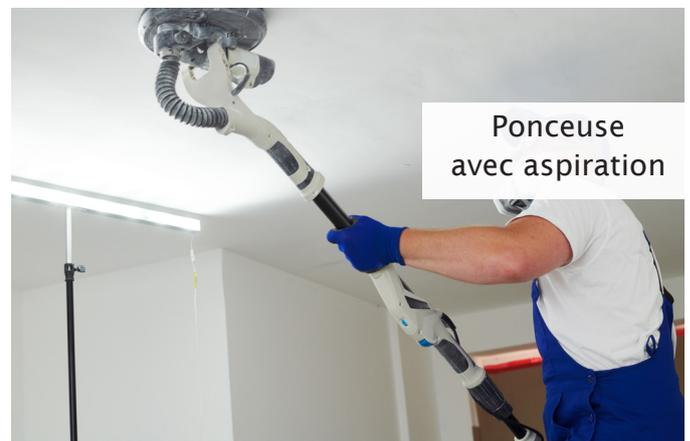
→ L'utilisation de machines équipées d'aspiration permet de réduire considérablement l'exposition des salariés à la silice cristalline.
